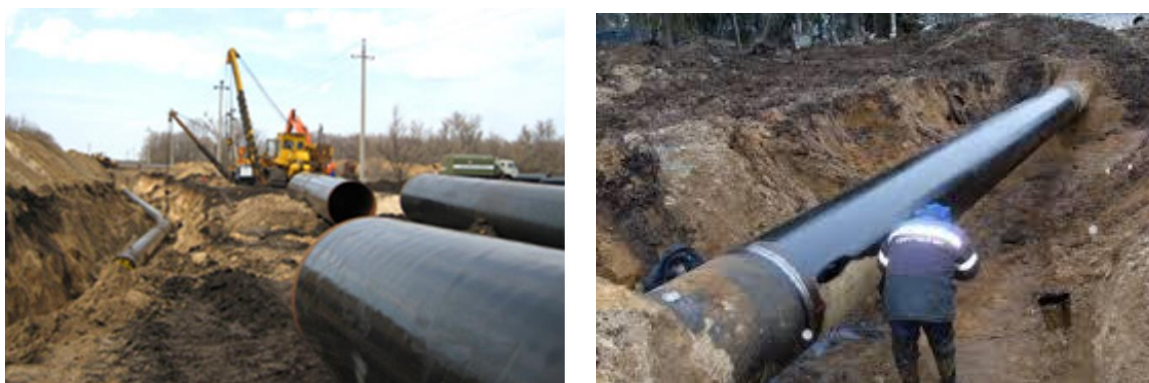
Рис. 2.6. К задаче № 2.2.2. Ремонт трубопроводов: удаление поврежденного участка и вставка нового
